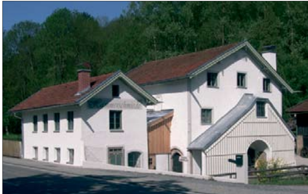
Die Hammerschmiede heute – nach umfangreicher Renovierung der Gebäude. Im 1. Stock des Hauptgebäudes soll ein Hammerschmiedemuseum entstehen. (Foto: Wagenhofer)
